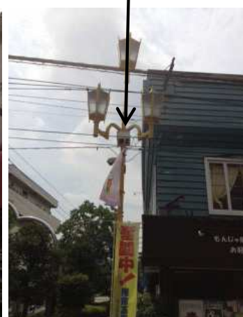
荏原町商店街 街灯スピーカー
